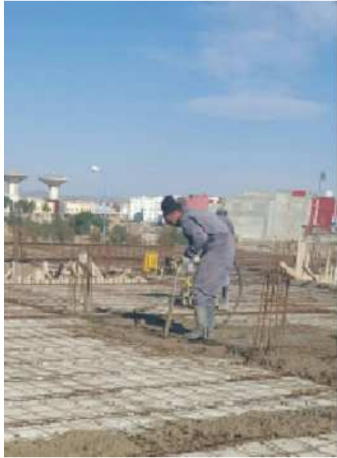
Figure 42 : vibrage du béton
