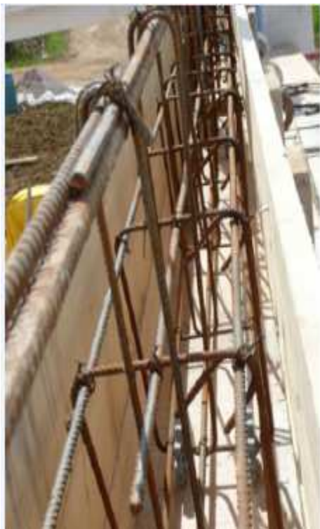
Figure 36 : coffrage de poutre
