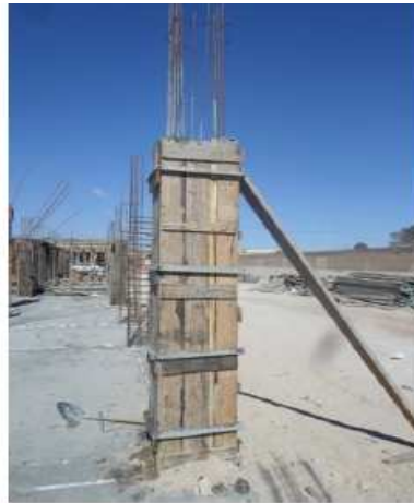
Figure 30: ferrailage de poteau Figure 31 : coffrage de poteau Figure 32 : décoffrage de poteau
