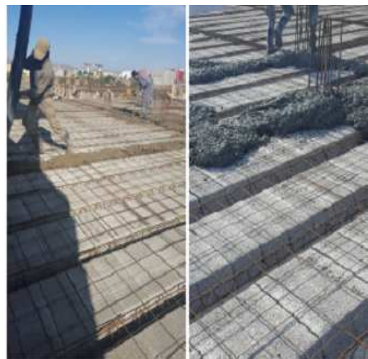
Figure 41 : collage du béton
