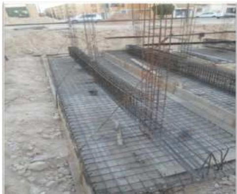
Figures 45 : Ferrailage de semelle filante
