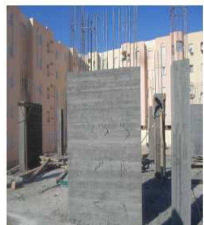
Figure 35 : décoffrage de voile
