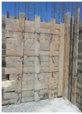
Figure 34 : coffrage de voile
