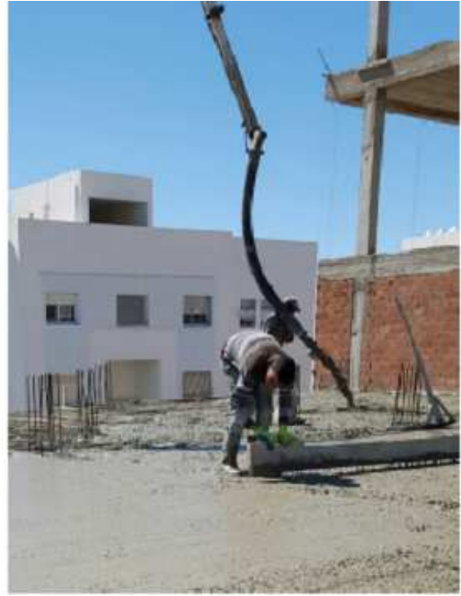
Figure 43 : réglage du béton
