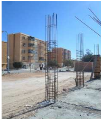
Figure 30: ferrailage de poteau Figure 31 : coffrage de poteau Figure 32 : décoffrage de poteau
