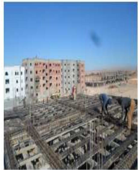
Figure 39 : ferrailage de plancher
