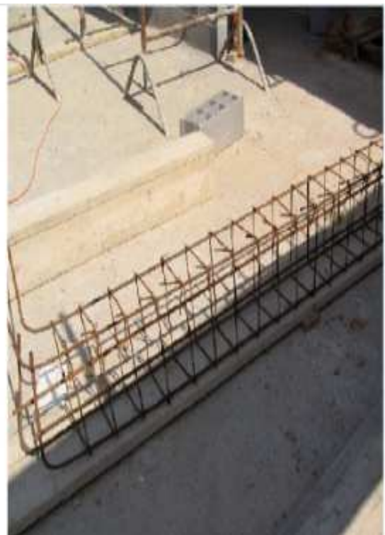
Figure 37 : ferrailage de poutre
