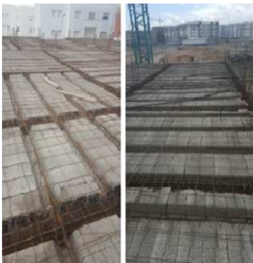
Figure 40 : posage des hourdis et poutrelles
