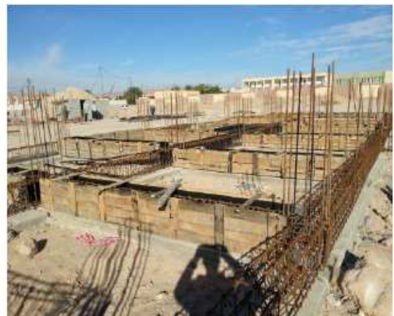
Figure 50 : ferrailage et coffrage de longrine
