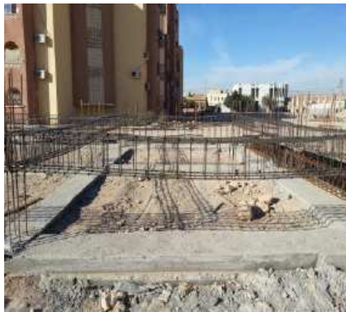
Figure 49 : Gros béton de longrine
