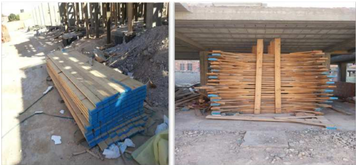
Figure 22 : stockage du bois de coffrage
