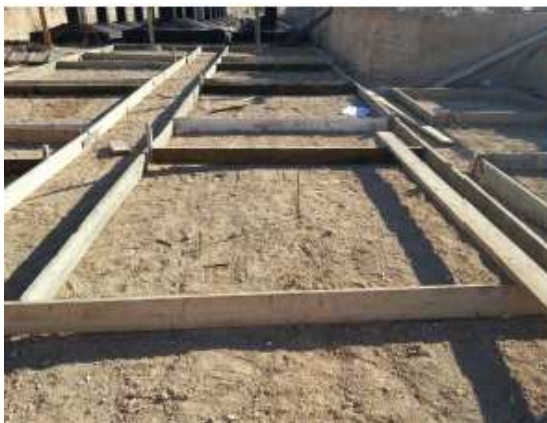
Figure 28 : coffrage de béton de propreté
