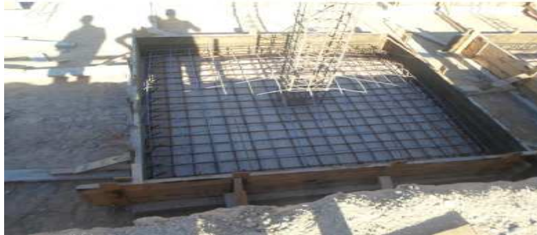
Figures 44 : Ferrailage et coffrage de semelle carrée
