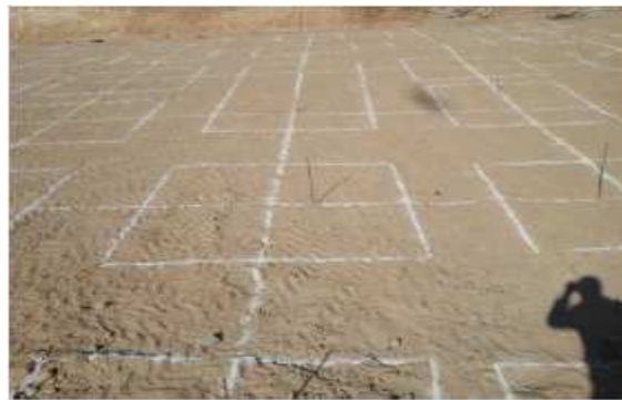
Figure 27 : le piquetage et traçage
