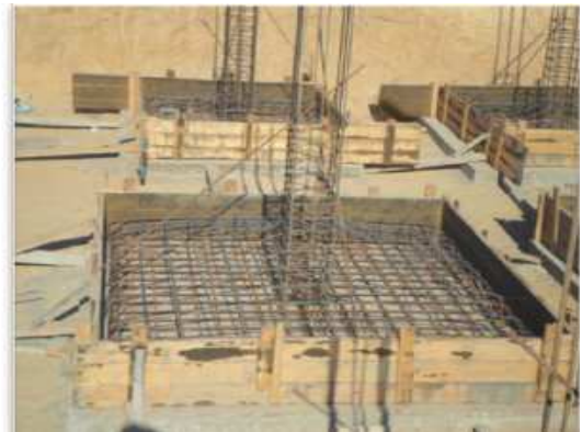
Figures 46 : Ferrailage et coffrage
