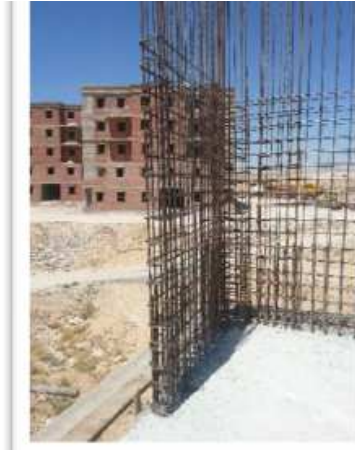
Figure 33 : ferrailage de voile
