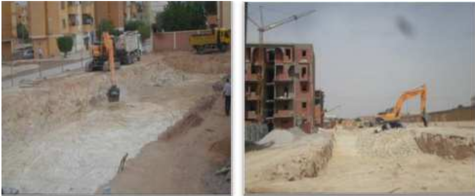
Figures 25 : terrassement de terrain
