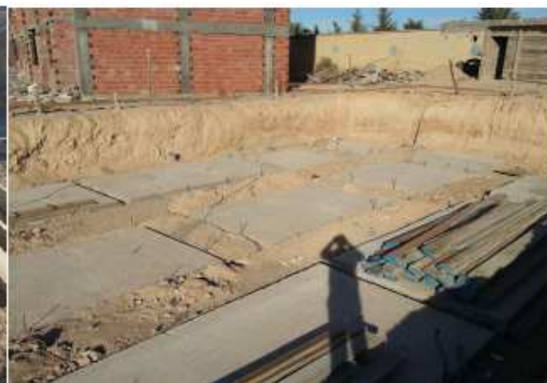
Figure 29 : béton de propreté
