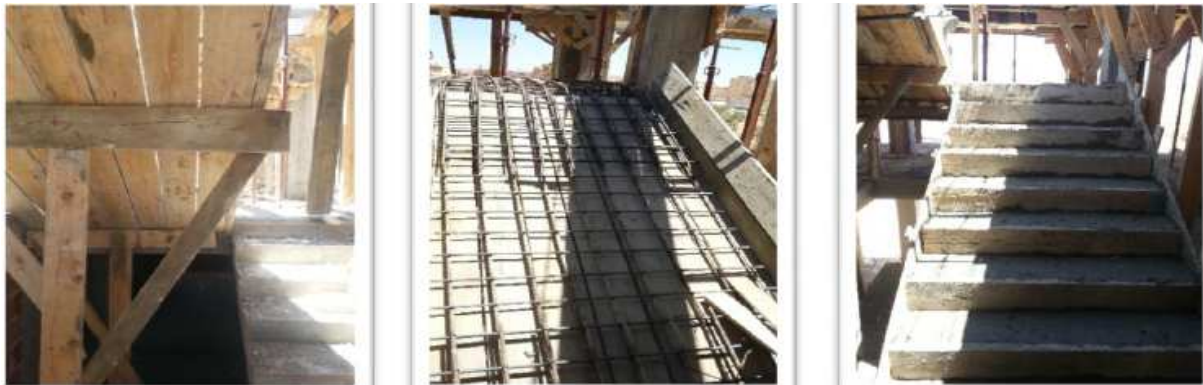
Figure 51 : coffrage d'escalier Figure 52 : ferrailage d'escalier Figure 53 : coulage d'escalier
