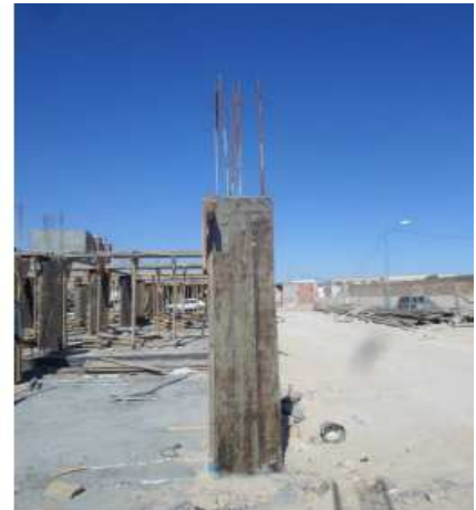
Figure 30: ferrailage de poteau Figure 31 : coffrage de poteau Figure 32 : décoffrage de poteau
