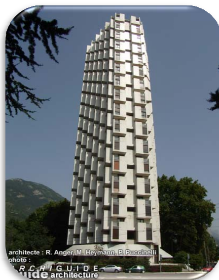
Figure 2 : la tour de l'Île Verte à Grenoble
