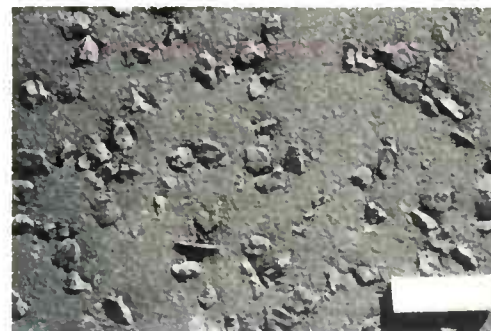
Sable enrobé clouté
