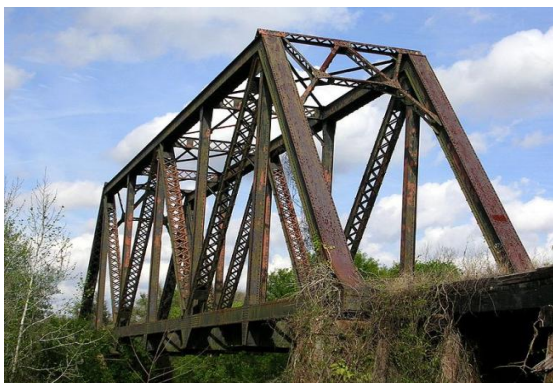
Pont à treillis de type Warren de la ligne ferroviaire « Seaboard Air Line Railway », situé près du village de Willow, Floride.
