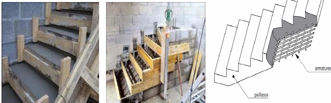
Figure.3.16 Escalier coulé en place.
