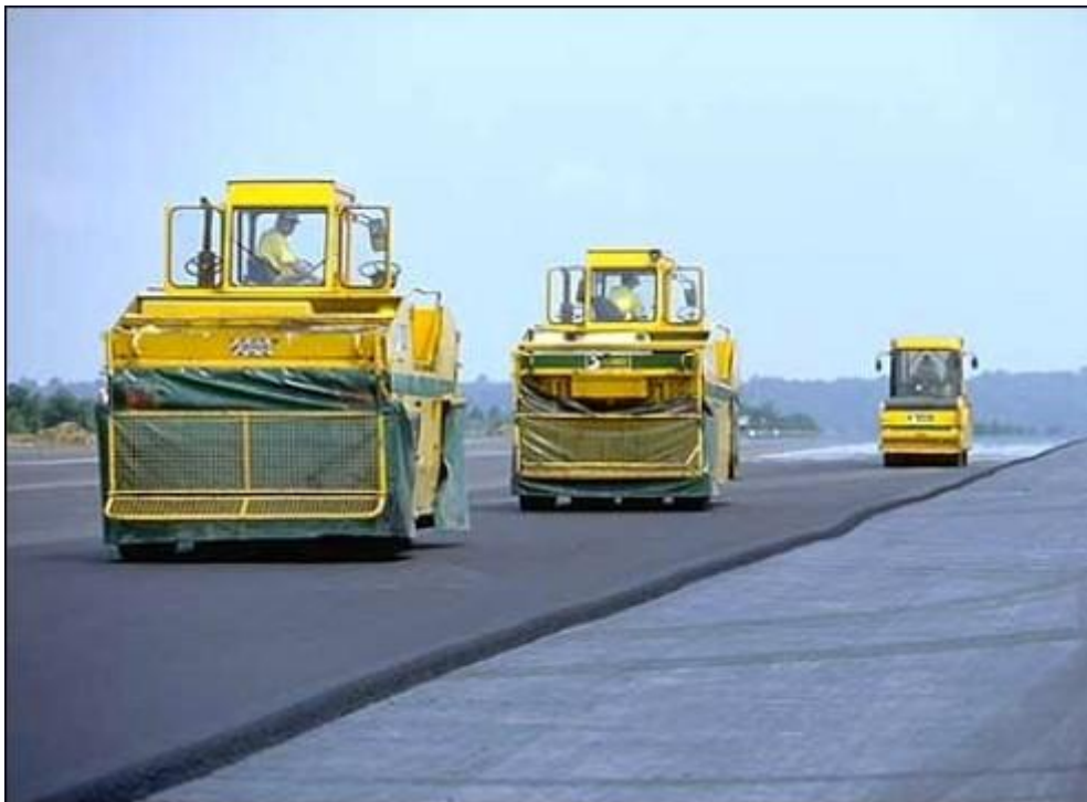
Vue montrant un atelier de compactage comportant des compacteurs à pneus et un compacteur vibrant lisse.
