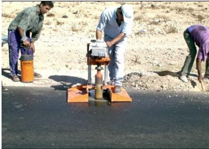
Vue montrant le carottage d'une couche d'enrobé
