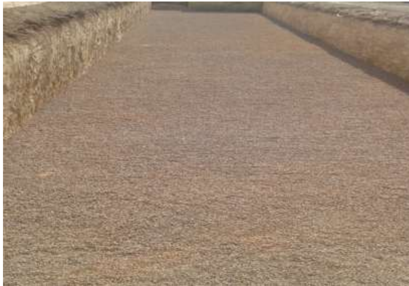
Figure 20: Lit de pose en gravette 8/15 d'épaisseur 0.30m
