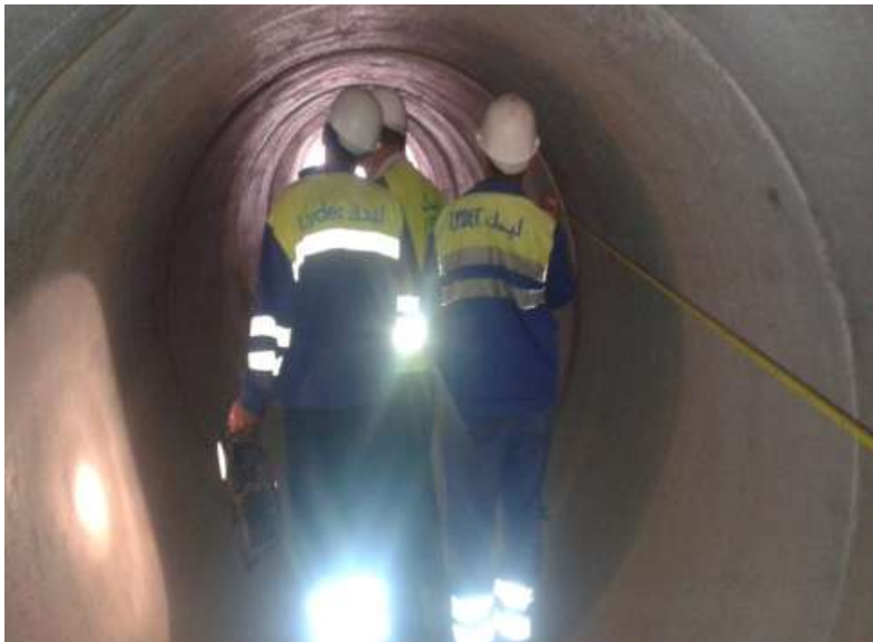
Figure 23; Contrôle visuel des joints d'étanchéités des buses de stockage
