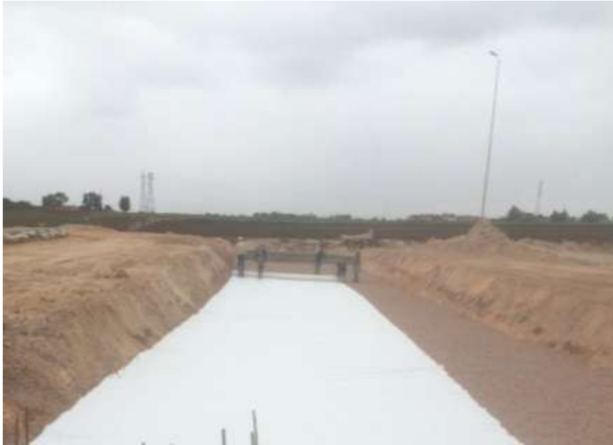
Figure 24 : Mise en place du géotextile sur le remblai primaire
