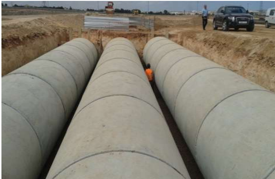
Figure 22 : Mise en place des buses de stockage
