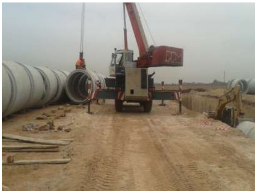
Figure 21 : Le bardage et la pose des buses par une grue mobile
