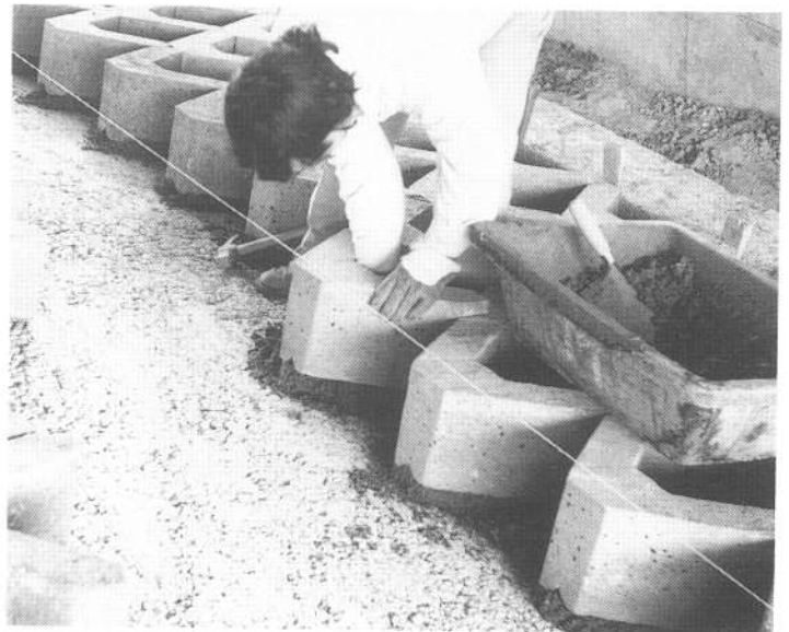
figure 36 Mise en oeuvre des dallettes ajourées.
