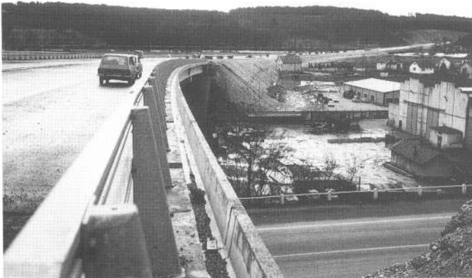
Figure 1 Vue de l'ensemble en place
