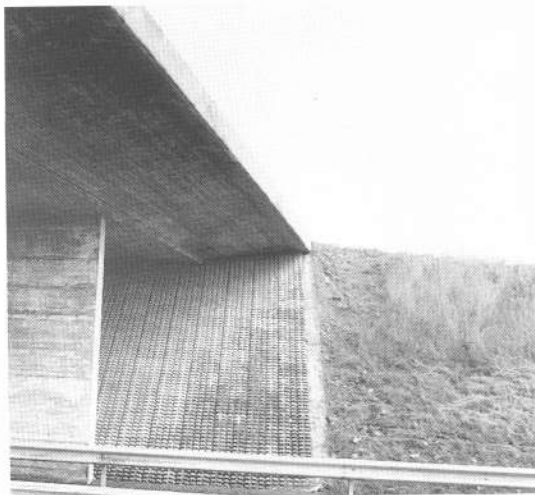
figures 7 et 8 Deux exemples de surface de perré. A gauche dalle Evergreen, Gobimat, ou similaire. A droite pavés ronds sans jointolement.
