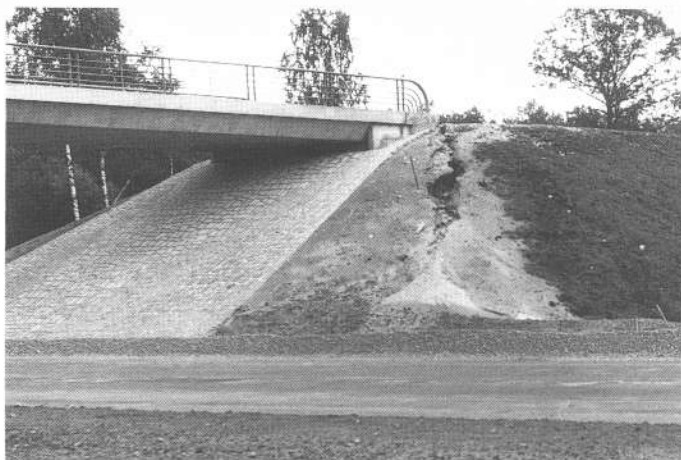
Figure 16 - Evacuation des eaux aux extrémités de l'ouvrage
