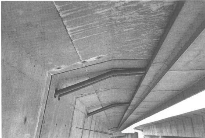
Figure 8 Evacuation intermédiaire avec renvoi dans un caisson
