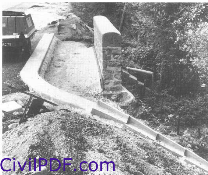
d) Descentes d'eau sur remblai et liaison avec le fil d'eau. Noter l'emploi, rare, de caniveau en béton préfabriqué (type CC).
