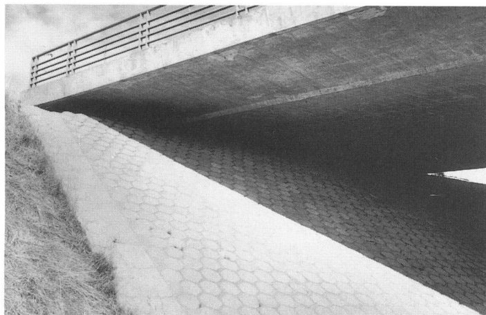
figure 15 Dallettes rondes non jointoyées.
