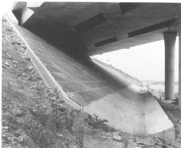
figure 30 Cunette de pied de perré. Noter la bordure coulée en place.
