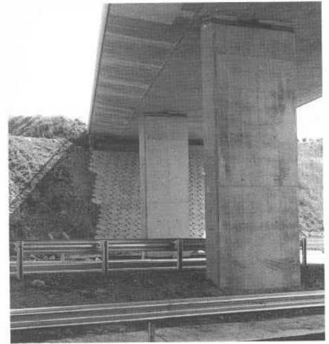
figures 7 et 8 Deux exemples de surface de perré. A gauche dalle Evergreen, Gobimat, ou similaire. A droite pavés ronds sans jointolement.
