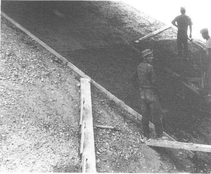
figure 33 Exécution de la fondation.
