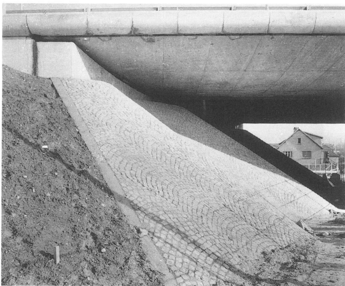
figure 12 Pavés de réemploi et perré à surface modelée.
