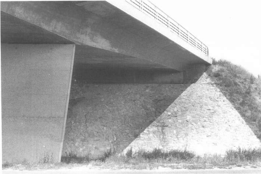
figure 6 La ligne d'ombre matérialise la zone exacte qu'il aurait été souhaitable d'équiper d'un perré. Ici un perré en opus incertum.
