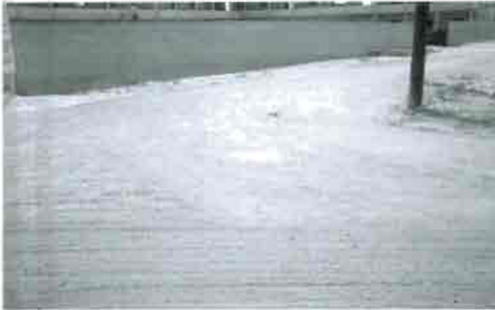
Figure 4. Voirie existante dans la Zone de Recasement en latérites stabilisées
