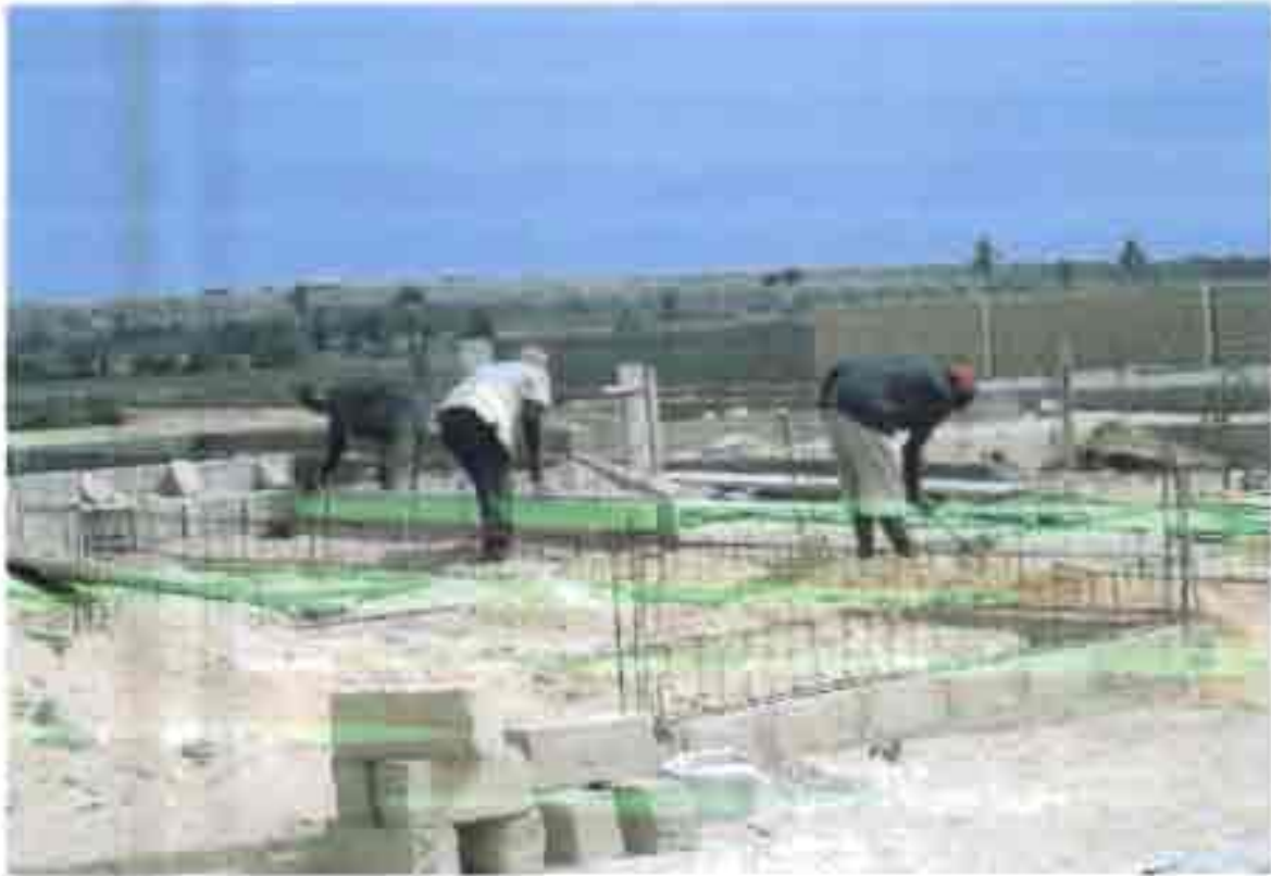
Centre Polyvalent en construction
